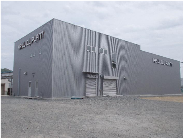
図1 (株) 國洋イサダオイル工場外観
