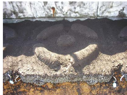
図13 試験施工 覆土状況（平成18年8月）
