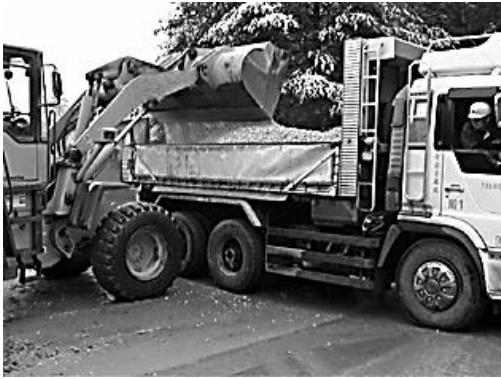
図5 積み込み状況
