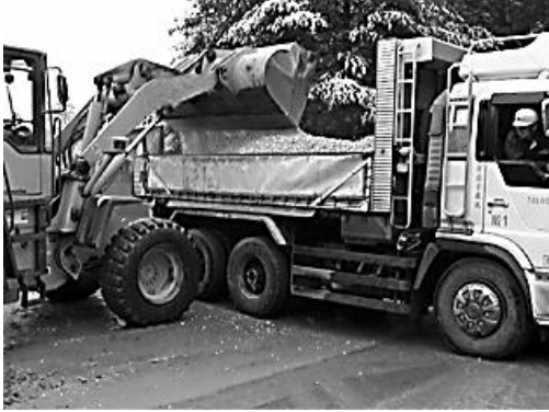
図5 積み込み状況
