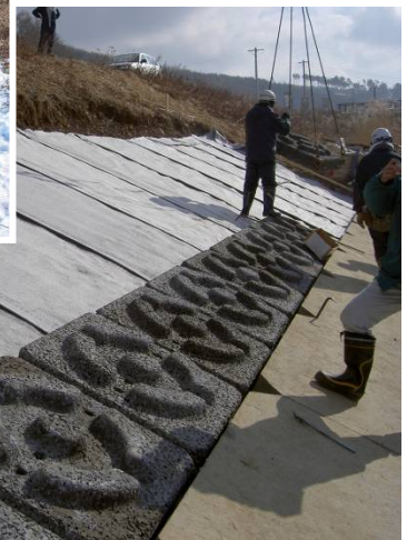
軽米地区河川工事状況（平成20年2月）
