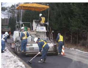
図3 アスファルト試験舗装
