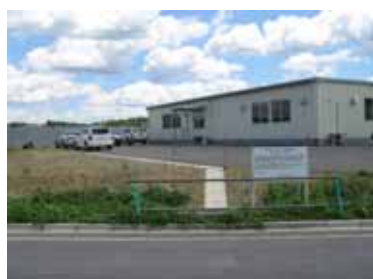
図1 U形側溝試験施工全景
