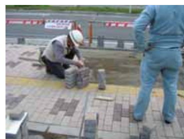
図5 インターロッキングブロック試験施工
