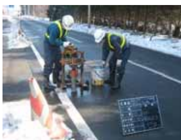
図4 コア抜き取り試験
