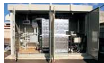
パッケージ型木質チップボイラー
