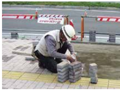
溶融スラグを使ったインターロッキングブロックの試験施工
