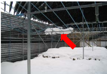
写真-3 単管パイプの残雪
