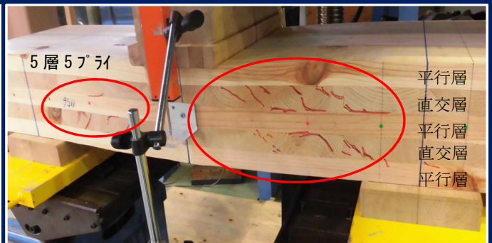
写真1 加力中に直交層に発生したせん断ひび割れ
