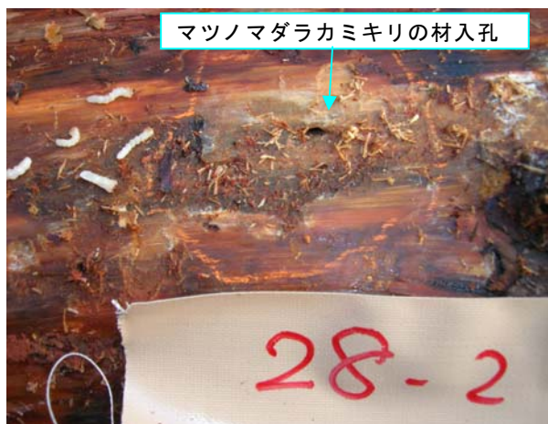
写真1 剥皮調査の状況(再加害を受けた熱処理丸太)
