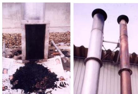
煙突内のスス(左)と異常燃焼で焼けた煙突(右)
