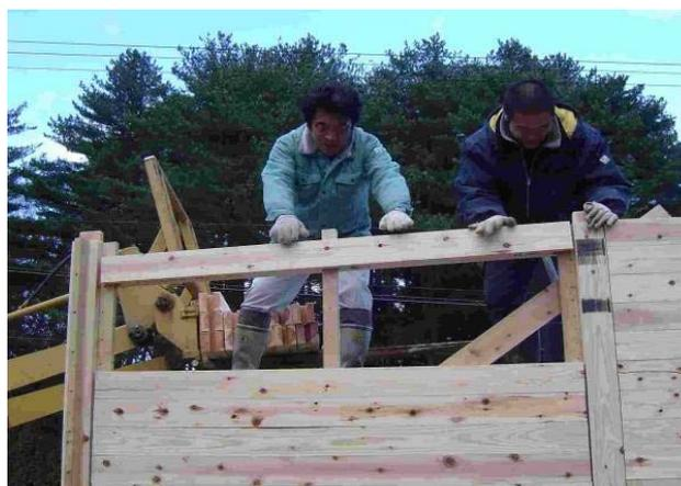
スギ正角材の壁材を落とし込む作業
