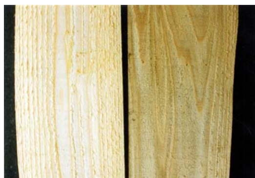
左：健全材 右：被害後1年経過材
