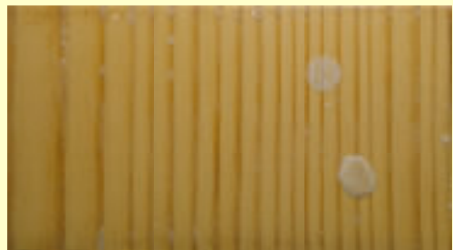
写真2 吸湿により薬剤が析出した表面
