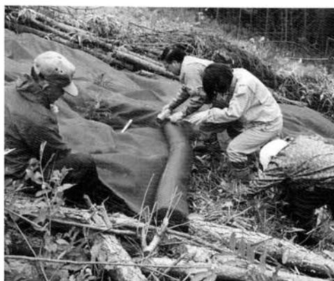
写真-2 ネット敷設作業の状況
