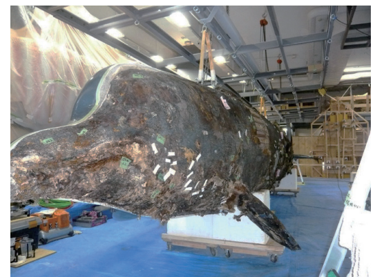
図8 FRPコーティングの除去(2012年3月) Fig. 8 Removing the FRP coat (March 2012)
