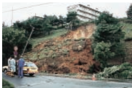
図4 大雨による盛岡市西松園2丁目の斜面崩壊。1995(平成7)年8月6日、当館第29回地質観察会(北上市)当日の朝撮影。
