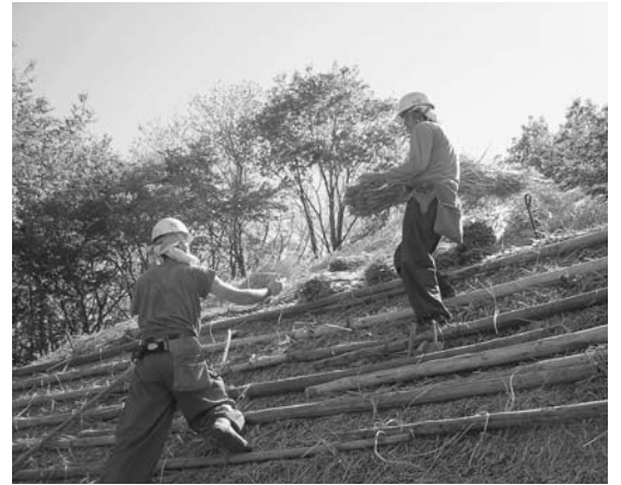
茅葺き作業中の『旧藤野家』
