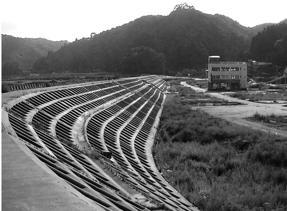
写真3 東日本大震災後の宮古市田老の防潮堤
