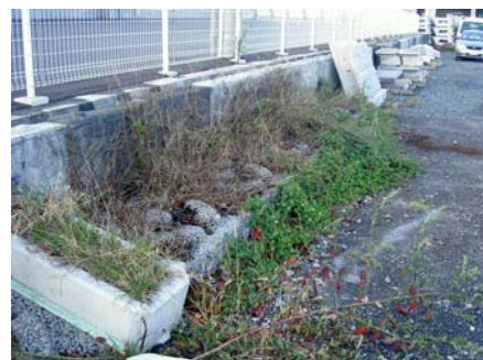
図14 施工後3ヶ月の状況（平成18年11月）
