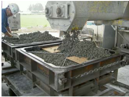
図8 ポーラスコンクリート打設状況
