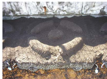
図13 試験施工 覆土状況（平成18年8月）
