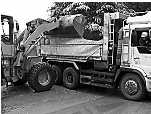
図5 積み込み状況
