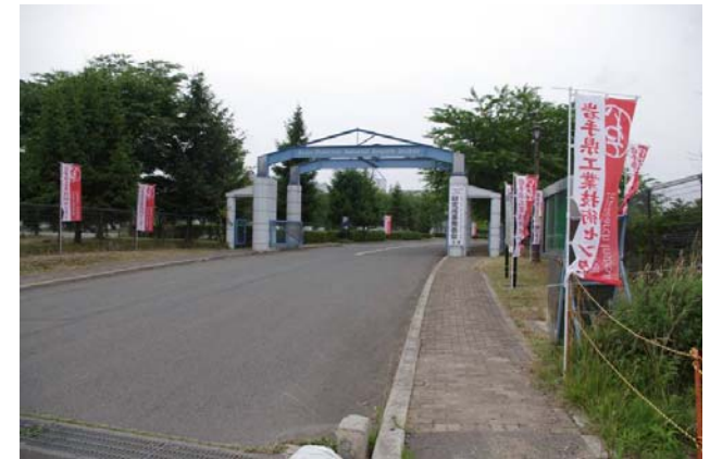
立て看板、のぼり旗設置状況
