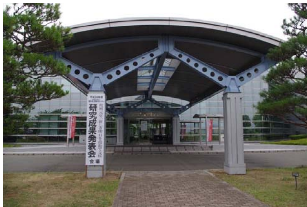
正面玄関前 立て看板設置
