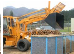
写真-5 ダストボックス詰込作業
