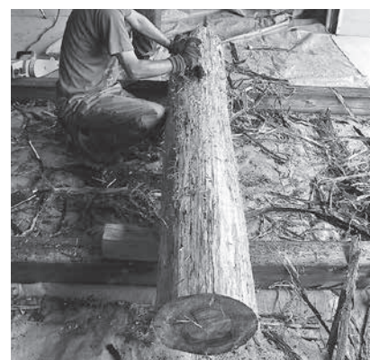
写真4 剥皮した丸太(焼損度「激」)
