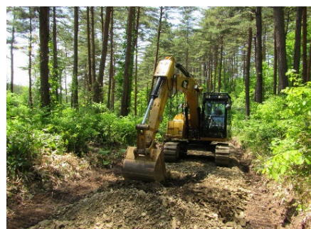
所有機械による作業道作設
