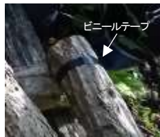
ビニールテープによる補修
