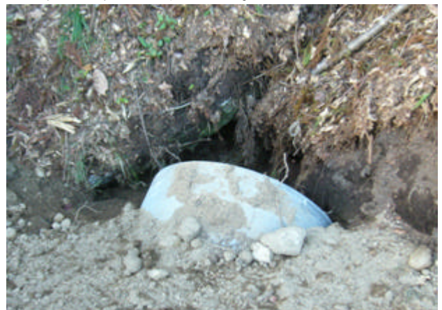
排水呑口の開削、流木止の設置を必要な状況改善
