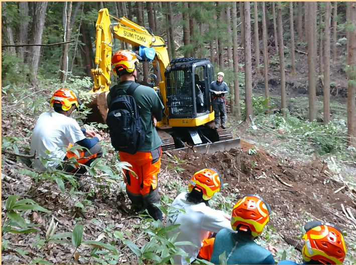
森林作業道の作設
