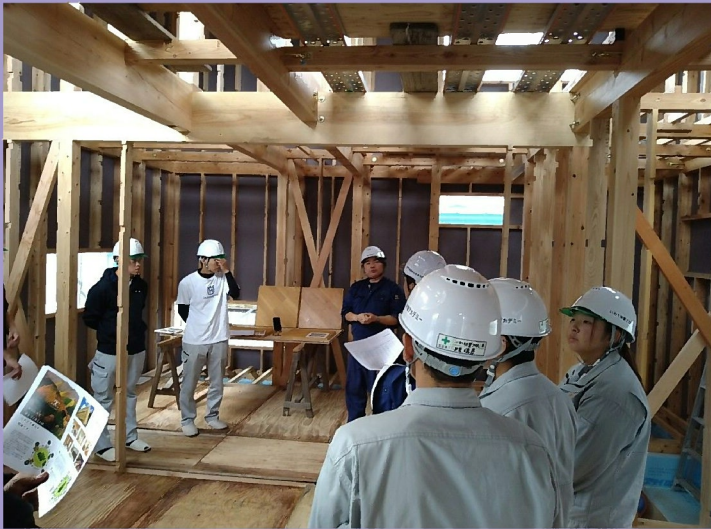
木造建築住宅現場
