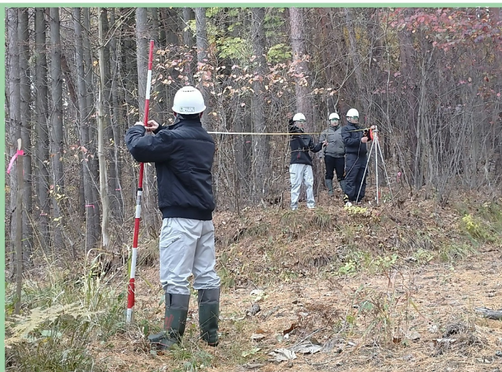
コンパス測量の基礎
