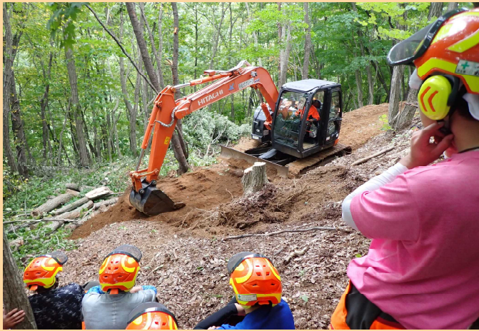
森林作業道の作設
