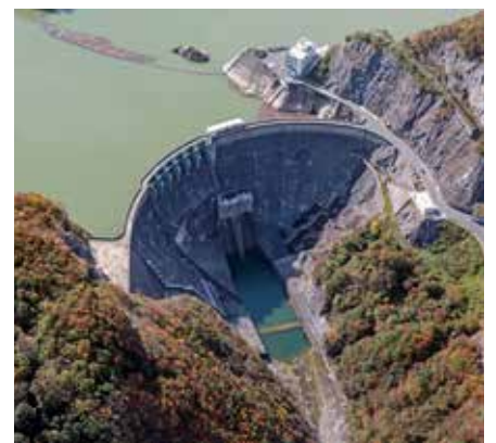
晩秋の湯田ダム(北上川ダム統合管理事務所画像提供)
