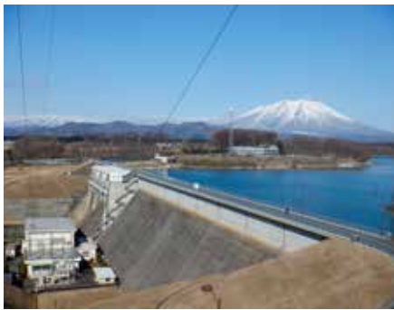
四十四田ダム コンクリートダムを主体に、左右岸がアースダムの複合ダム(北上川ダム統合管理事務所画像提供)
