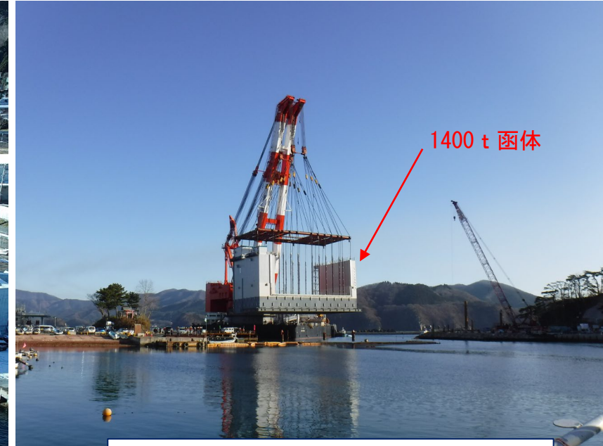
1800 t 吊起重機船での据付状況 1400 t 函体
