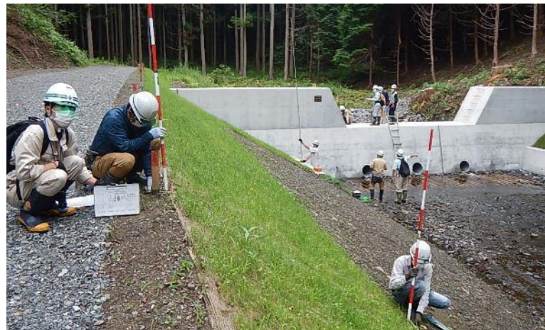
治山工事の完成検査
