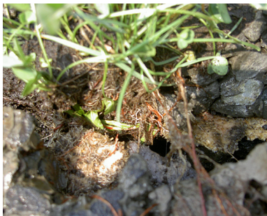
図8 ブロック内の保水性ボードと根張り状況
