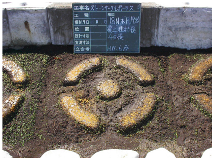
図6 覆土状況（平成17年6月）
