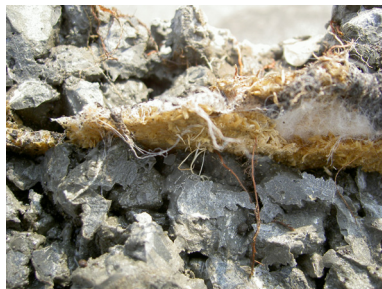
図9 ブロック内の保水性ボードと根張り状況
