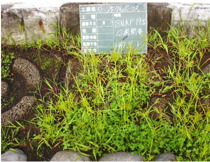
図7 施工後12週間の状況（平成17年9月）
