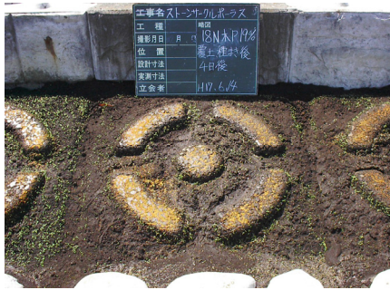
図6 覆土状況（平成17年6月）
