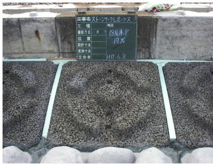
図5 施工状況（平成17年6月）
