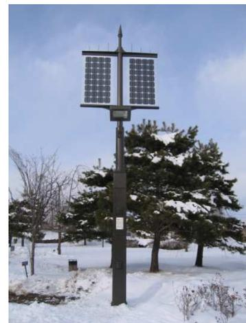
図2 当センターに設置した両面受光型太陽電池モジュール及びソーラーLED街路灯
