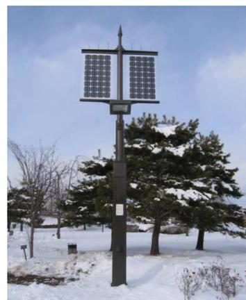
図2 当センターに設置した両面受光型太陽電池モジュール及びソーラーLED街路灯
