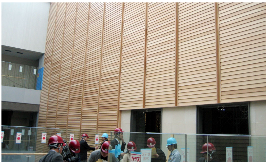
図 1. 施工中の“いわて準不燃スーパーパネル”
