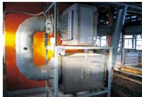
農場に設置した光触媒循環換気装置
