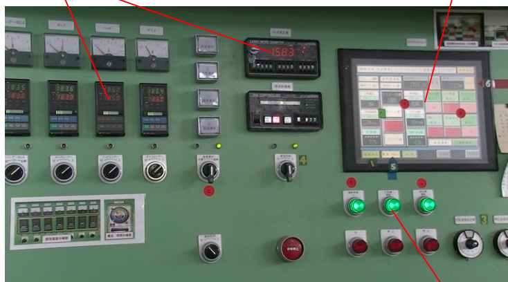
製造装置の制御盤
