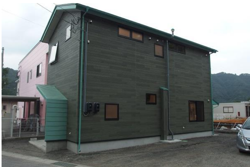
木工場外観（販売店舗併設）
