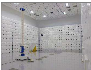
大型電波暗室
