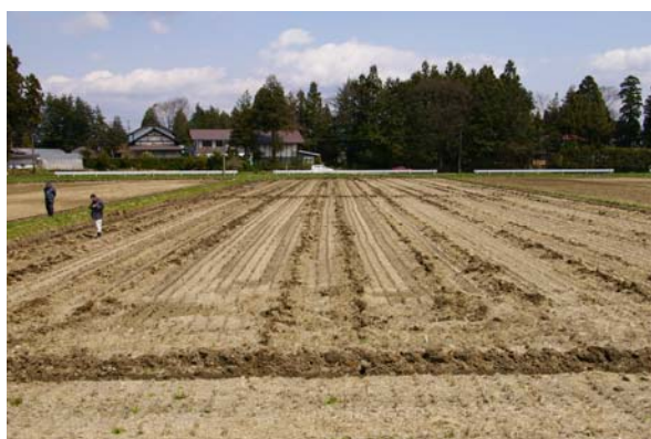
写真1 額縁明きよ及び弾丸暗きよの施工 (4/28)
