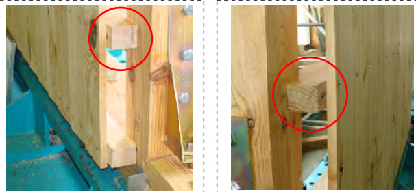
写真1 小幅板と幅はぎ板の破壊形態の比較
