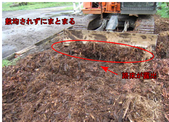
写真1－排土板での敷均しによる樹皮の集塊
