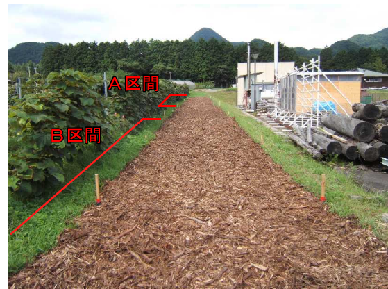
写真2－施工完了状況
