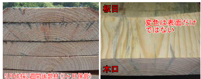
写真2ーカビによる板内部の変色
