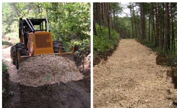
写真2 チップの敷き均し状況(左)と完成状態(右) (担当 林産利用部 主任専門研究員 多田野 修)
