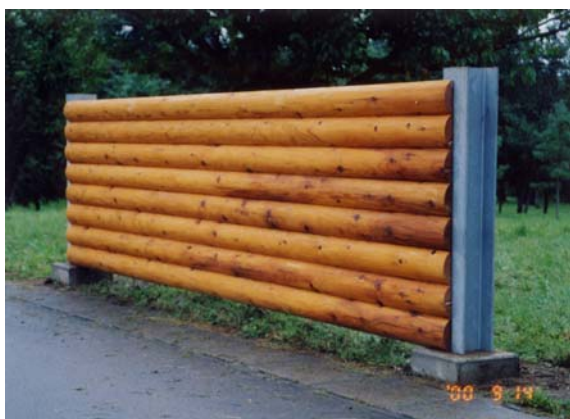
試作した木製遮音壁
