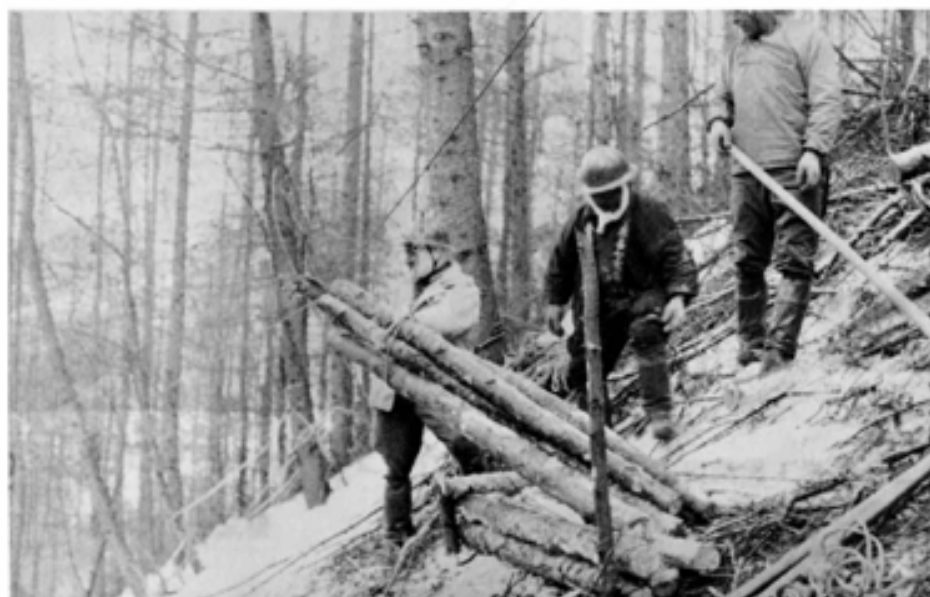
写真-5 ジグザグ索道の積み込み
