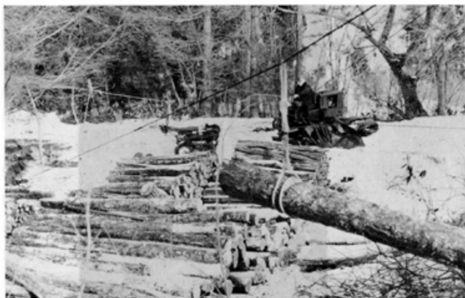
写真-6 ジグザグ索道の土場
