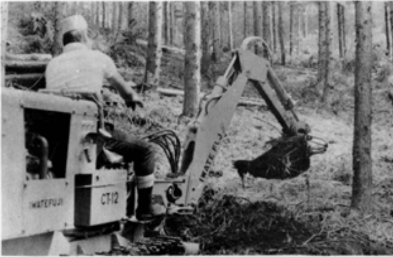
写真-1 バックホーによる作業道作り
