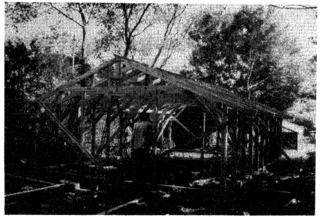
写真一七 軸組みの外観
