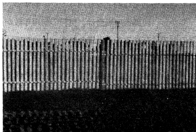
写真－4 完成した防風柵の外観
